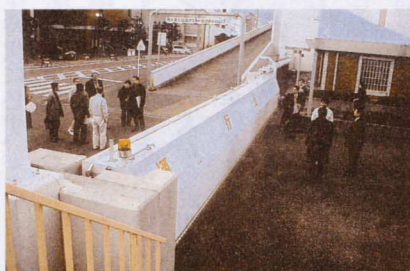
▲ 津波対策事業 可動式防潮堤調査 （静岡市）
